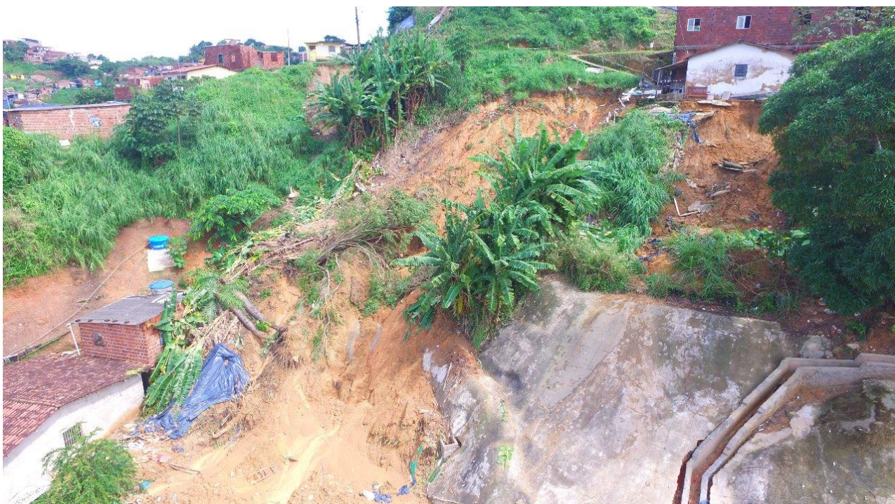
Deslizamento de encosta na 2ª Trav. Bom Jesus – Bairro dos Estados (13/06/2019)
