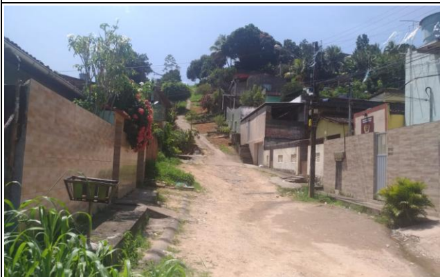
Foto n. 01: ENTRE A ESTACA 00 E 011
