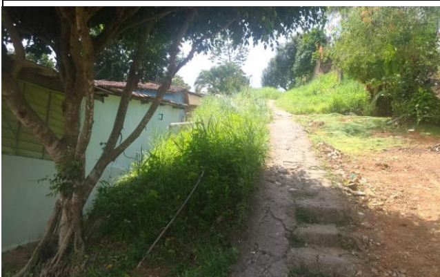
Foto n. 09: ENTRE A ESTACA 05 E 06
