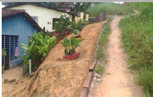
Foto n. 07: ENTRE A ESTACA 04 E 05
