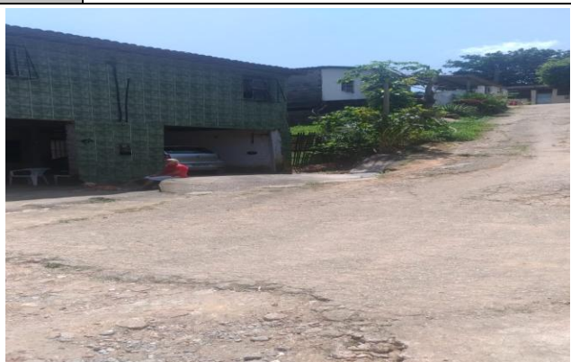
Foto n. 11: ENTRE A ESTACA 06 E 07
