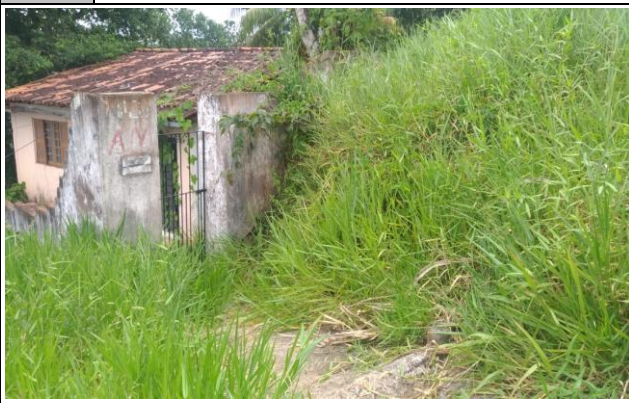
Foto n. 04: ENTRE A ESTACA 03 E 04
