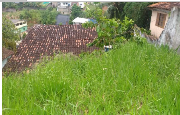
Foto n. 06: ENTRE A ESTACA 03 E 04
