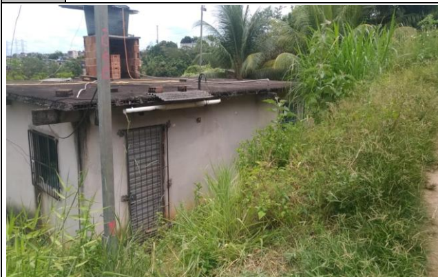
Foto n. 03: ENTRE A ESTACA 02 E 03
