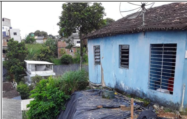
Foto n. 08: ENTRE A ESTACA 04 E 05
