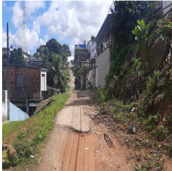
Foto n. 52: RUA GOIAS – SANTANA
