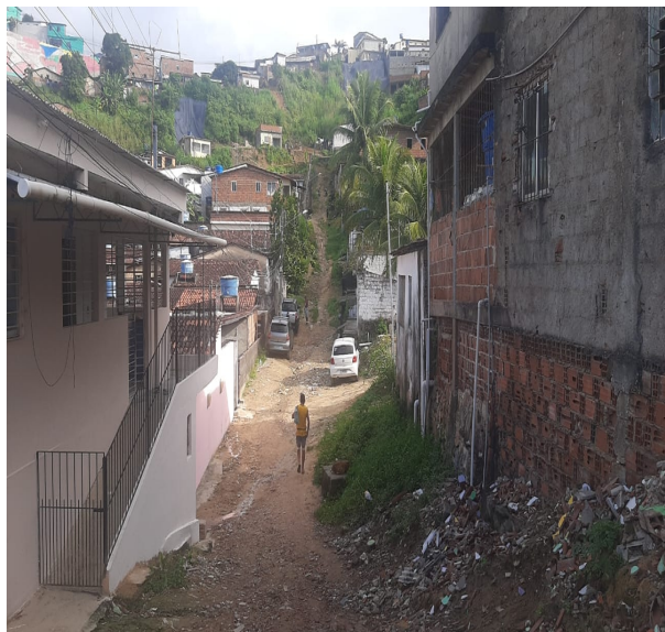
Foto n. 49: RUA NOVA LONDRINA – BAIRRO DOS ESTADOS
