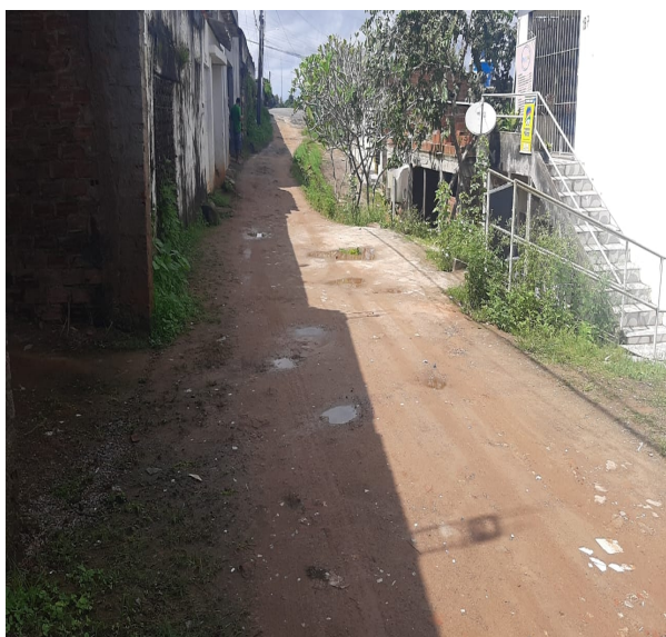
Foto n. 51: RUA GOIAS – SANTANA
