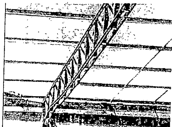
F18- Detalhe da deformação por empenamento de torção na terça de sustentação do telhado
