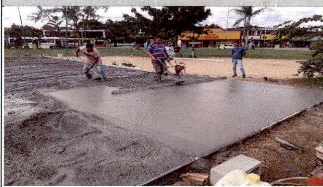
Foto n. 07: ACABAMENTO DO CONCRETO
