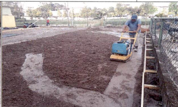
Foto n. 02: COMPACTAÇÃO DO SOLO
