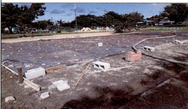
Foto n. 05: ÁREA PRONTA PARA CONCRETAGEM
