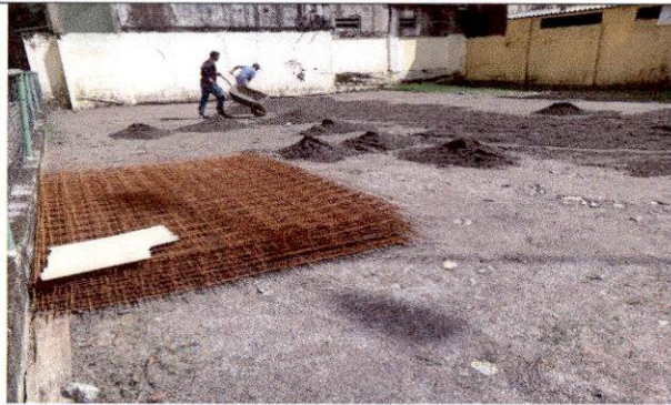
Foto n. 01: REGULARIZAÇÃO DO TERRENO E MELHORAMENTO DO SOLO
