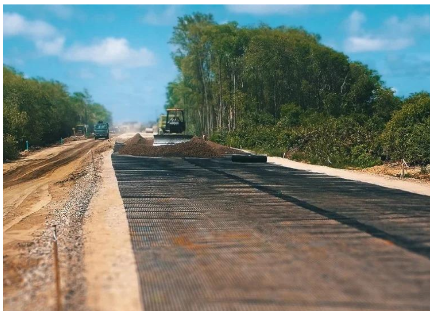
Aplicação de Geogrelha em via
